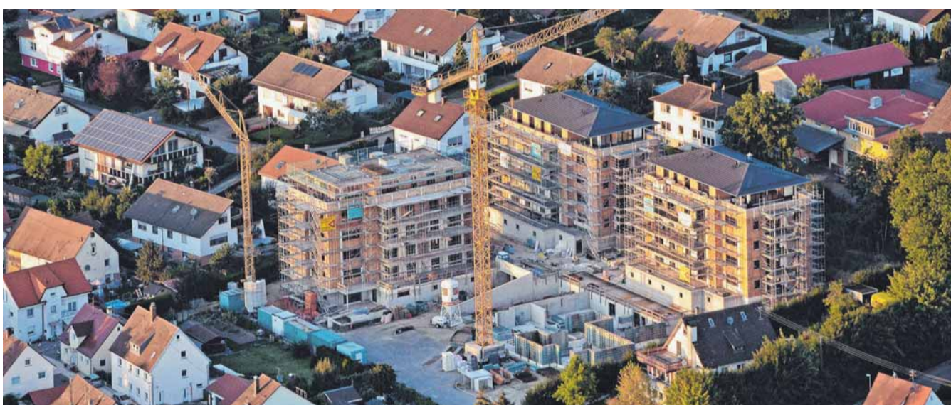
Eingebettet in die Umgebungsbebauung, entstehen am Kellerberg 54 neue Wohnungen.
