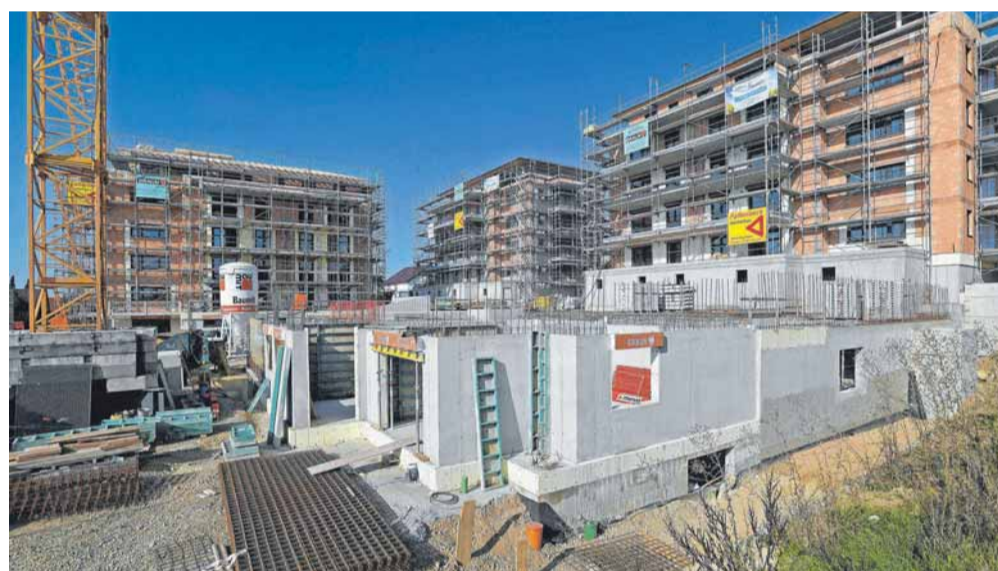
Im vierten Gebäude ist gerade der Keller betoniert.
